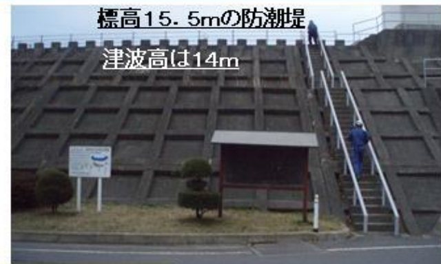
普代村の勝利 2/2(太田名部の防潮堤)
