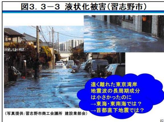
液状化は地震の揺れによって土の構造が壊れて、土粒子や砂と地下水が混ざって液体状(懸濁液)になる現象で、地盤が柔らかく地下水位の高い所、すなわち埋立地や河川沿いなどで発生します。懸濁液となった層にその上の地盤の荷重がかかると圧力が上昇し、地層の隙間から懸濁液が地上に吹き上げ(噴砂現象)たり、懸濁液の中ではマンホールなど軽いものが浮かび上がり、逆に重たいものは沈みます。南海トラフ地震や首都直下地震でも、広範囲に液状化現象が発生します。たとえ、地震の揺れによる建物被害がなかったとしても、液状化現象が発生した場合には建物が沈み傾く可能性があります。
