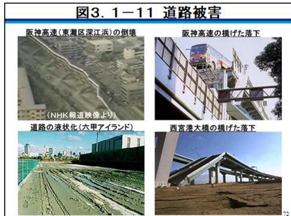
阪神淡路大震災では橋脚の倒壊や橋げたの落下が起き、湾岸部では激しい液状化も起きました。道路橋についても橋脚の耐震補強や、橋桁の落下防止が全国で進められましたが、橋桁の開きや、横ずれといった橋桁移動は防ぎきれません。大きな地震では道路網が寸断されます。
