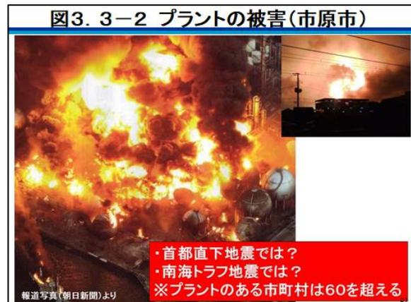
このようなプラントの大火災は1964年の新潟地震での新潟市、2003年の十勝沖地震での苫小牧市でも発生しました。市原市の石油プラント火災はメンテ中のタンクの配管が損傷して出火したようですが、新潟市や苫小牧市の被害は、長周期地震動によって石油タンク内にスロッシング(液面動揺)が発生し、浮き屋根が損傷して火花が飛んだことが被害の原因だったようです。
