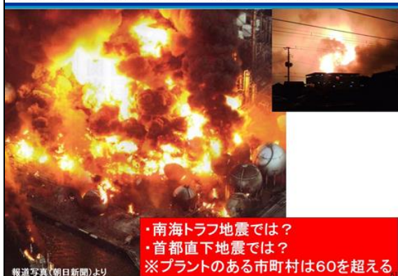
図2-30 東日本大震災でのプラント被害(市原市)
