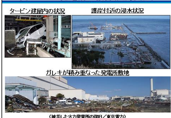
図2-29 発電所の被害(広野火力)
