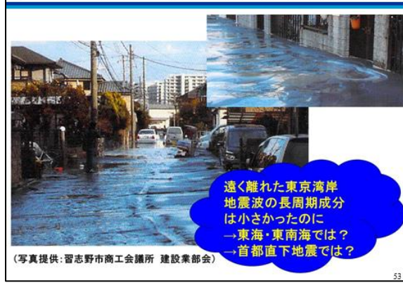
図2-24 東日本大震災での液状化被害(習志野市)
